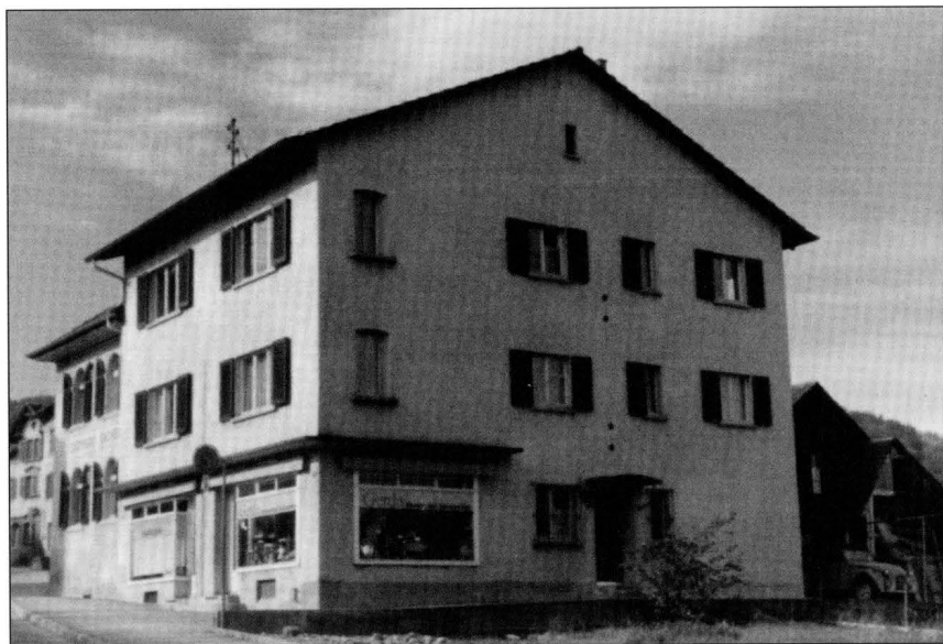
Die beiden Ladengeschäfte Radio Müller und das Bébé-Geschäft «Gerda» im Anbau am alten Bacher-Haus. Archiv: Bernhard Fuchs
